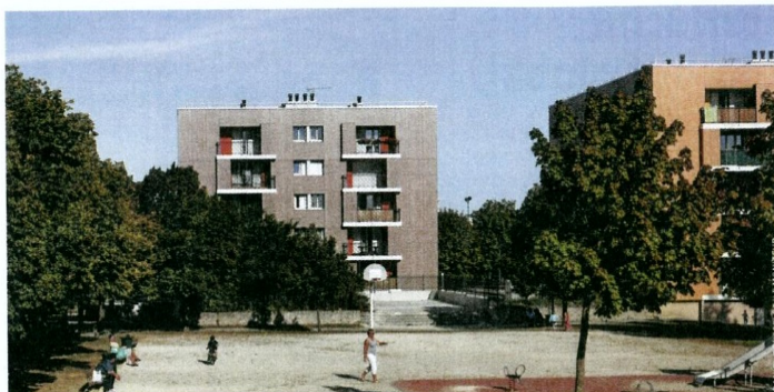
Le Foyer rémois achèvera fin 2013 la réhabilitation BBC des 500 logements qu'elle détient dans le quartier Orgeval, achevé en 1967, à Reims. Cari a remporté le projet à l'issue d'un dialogue compétitif.
