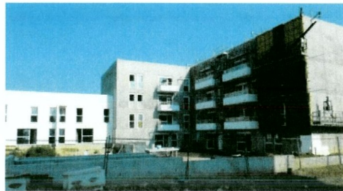
© FV Logements sociaux à Garges-lès-Gonesse (Groupe 3F)
