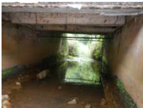
Fig. 6. EXEMPLE D'OUVRAGE COULÉ EN PLACE (PONT DE LA RN2 AU-DESSUS DE LA CRIQUE BALATA)
