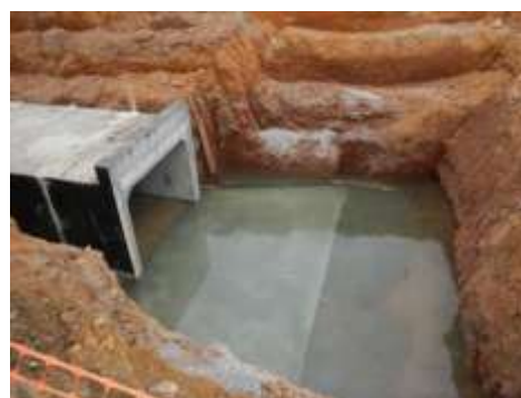
Fig. 5. EXEMPLE D'OUVRAGE PREFABRIQUE (A DROITE : BUSE EN PLACE, PRES DE SAINT LAURENT DU MARONI, A GAUCHE PONT CADRE LORS DE SA MISE EN ŒUVRE, ECHANGEUR DE BALATA)
