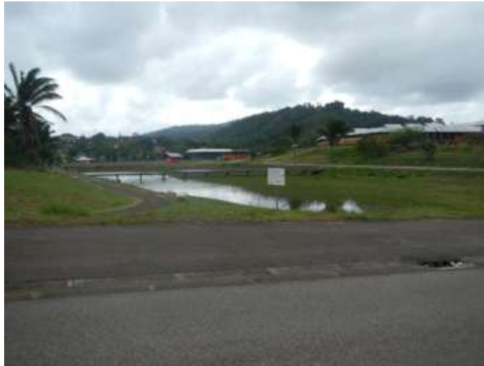
Fig. 13. BASSIN DE RETENTION AVEC VOLUME MORT A PROXIMITÉ DU LYCÉE BALATA (MATOURY)
