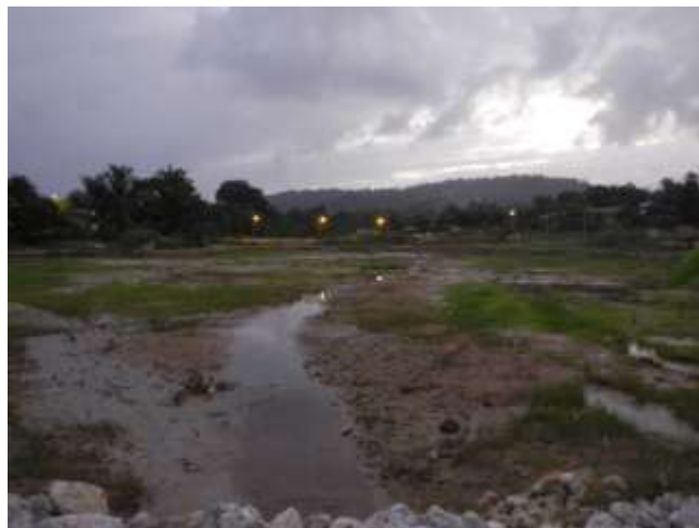
Fig. 12. BASSIN DE RETENTION A SEC DANS LE QUARTIER COTONNIERE-OUEST (MATOURY)
