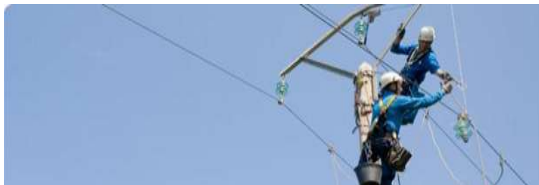
Fig. 17. ISOLATEUR RIGIDE
