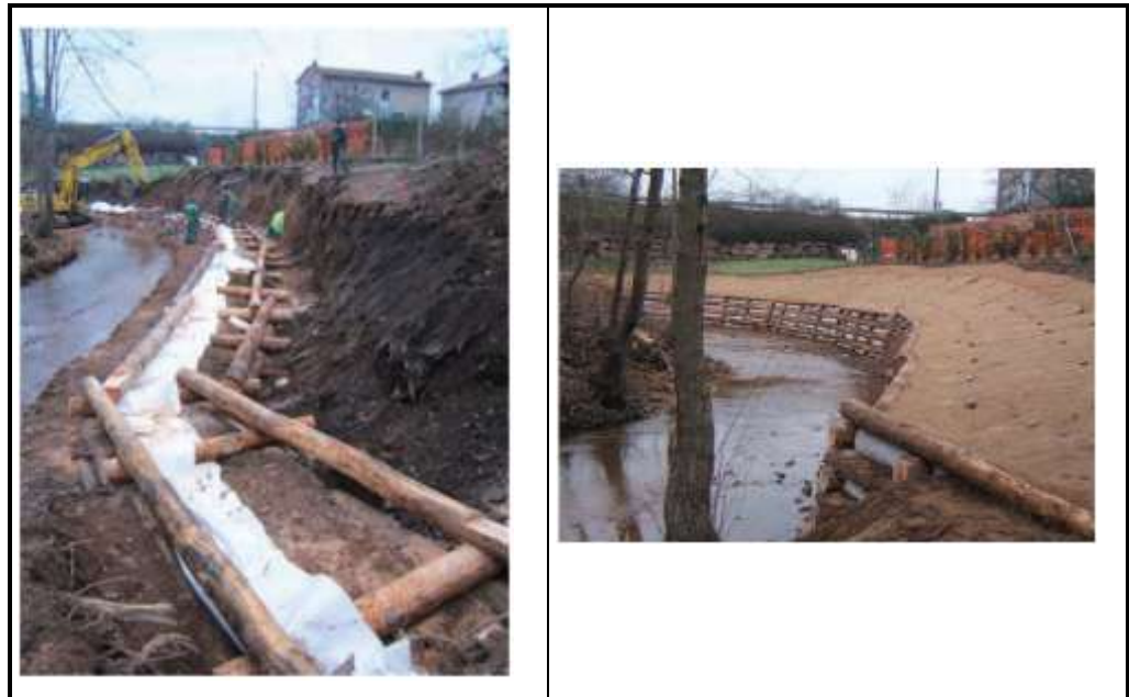
Fig. 16. EXEMPLE DE MISE EN PLACE DE CAISSON BOIS POUR LA PROTECTION DE BERGE (COM COM DU PAYS DE CHARLIEU)
