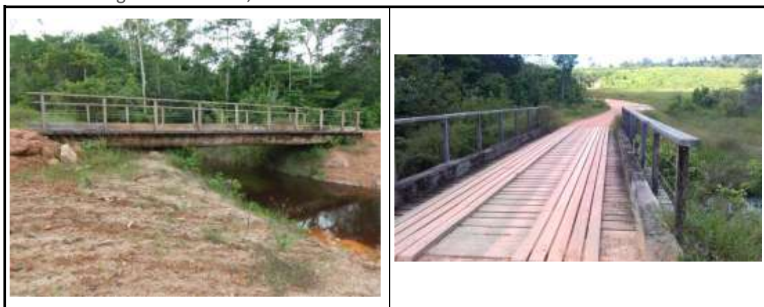
Fig. 7. EXEMPLE D'OUVRAGE DE FRANCHISSEMENT EN BOIS
