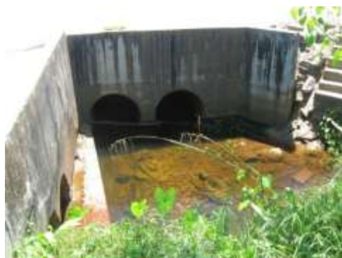
Fig. 5. EXEMPLE D'OUVRAGE PREFABRIQUE (A DROITE : BUSE EN PLACE, PRES DE SAINT LAURENT DU MARONI, A GAUCHE PONT CADRE LORS DE SA MISE EN ŒUVRE, ECHANGEUR DE BALATA)
