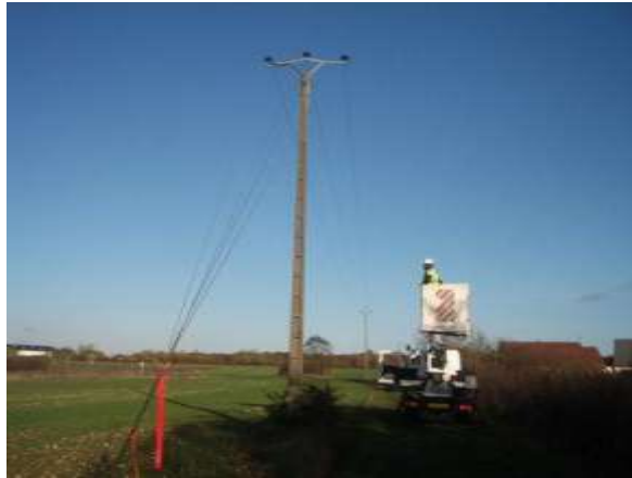
Fig. 18. SUPPORT EN COURS DE POSE
