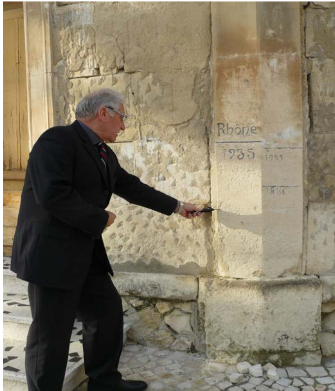
Repères de crues sur une maison de Boulbon
