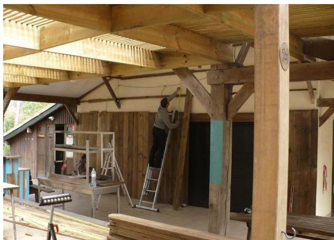
Mise en place d'un bardage en bois sur un bâtiment déjà construit
