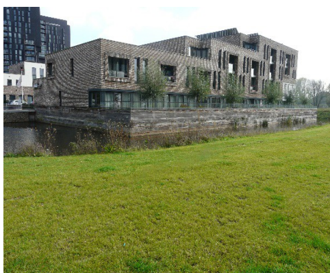
Une opération de logements en petits collectifs
