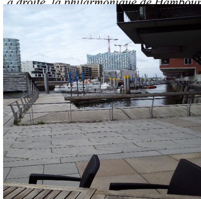
Une vue des quais «inondables» ; au fond, la philharmonique en construction.
