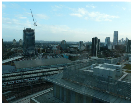
Le quartier olympique en cours de rénovation – construction.
