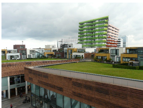
Le centre commercial et les logements individuels sur la couverture végétalisée du centre.
