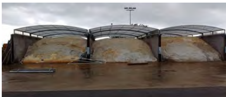
Hangar à sel au CEI de Limoges
