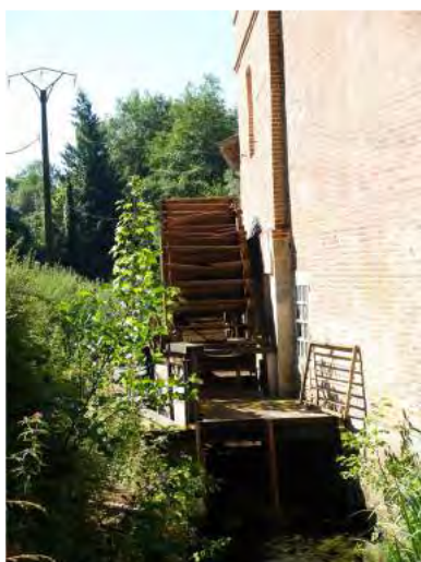
Roue et canal - Photo Source DM
