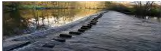
Grand moulin d'Artannes, sur l'Indre (Indre-et-Loire) Seuil du moulin Bodin à St Germain-s/-Moine (M.et-Loire)
