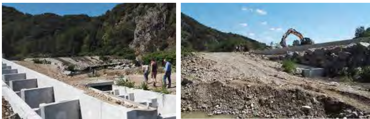
Le chantier de la passe à poissons
