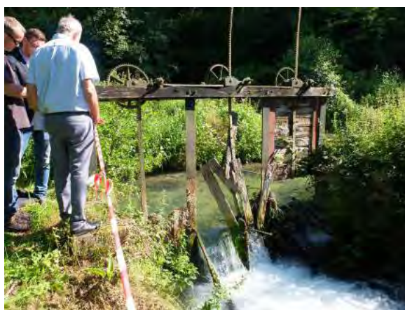
Vestige de vannes - Photo Source DM
