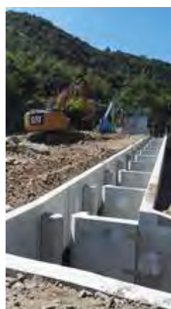
La construction de la passe à poissons
