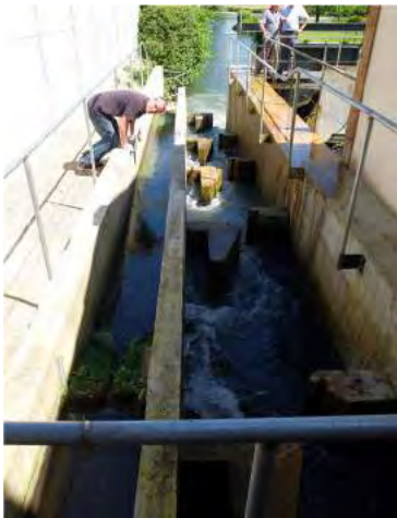
L'usine principale, avec de gauche à droite : passe à anguilles, passe à bassins multi-espèces, vis d'Archimède (ichtyocompatible)
