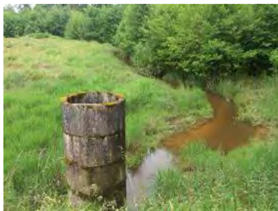
L'étang en amont et son "moine hydraulique" Source photo AB
