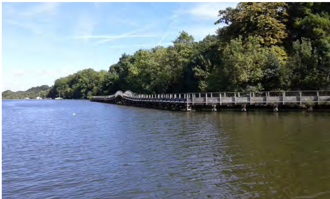
Passerelle de contournement de propriétés sur le DPF à Nantes
