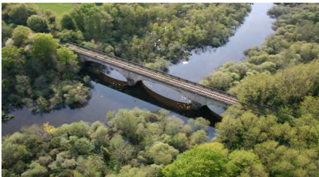
L'obstacle du vallon de l'Hocmard, affluent rive droite de l'Erdre, enjambé par le viaduc entre La Chapelle-sur-Erdre et Sucé-sur-Erdre
