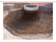
Photo n°5 : éolienne en cours de construction : la fondation s'arrête à un mètre en dessous du niveau du sol et est ensuite recouverte de terre.
