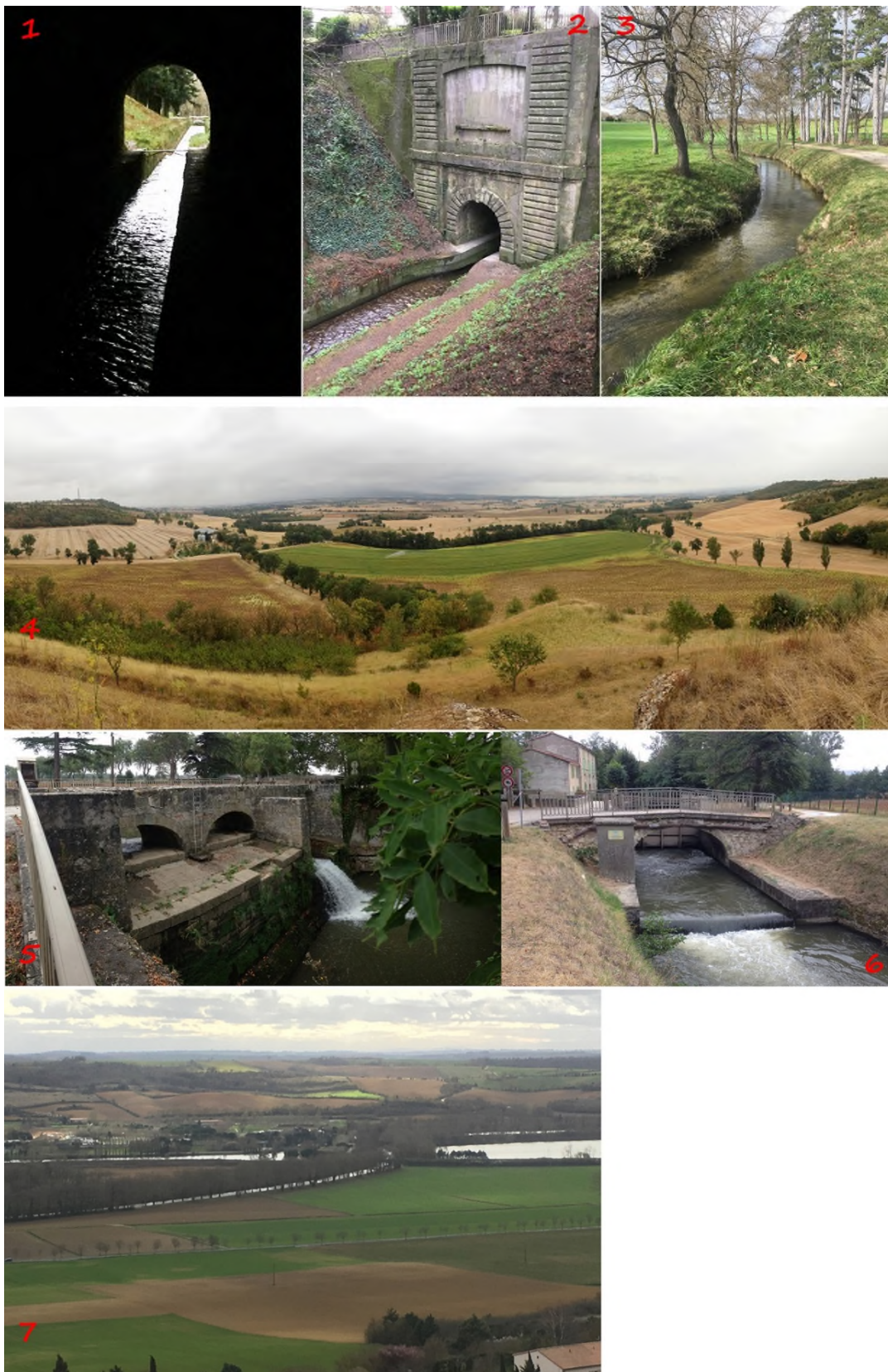
3. Images du système d'alimentation du Canal du Midi : Le tunnel des Cammazes (1&2) ; La Rigole de la Plaine à La Catalane (3) et dans les plaines du Lauragais (4) ; Le Laudot à la minoterie du château de Montcausson (4&5) ; le point de confluence de la Rigole de la Plaine et du Canal du Midi au seuil de Naurouze (7) – photos JMB sept. 2016 et mars 2019.
